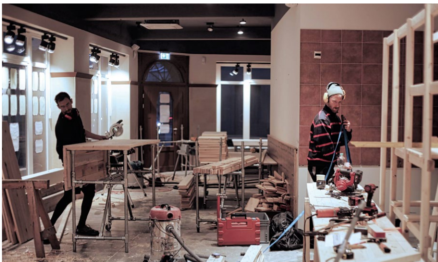
Abb. 1: Umbau in der ehemaligen Bäckerei (Fotos: Innenstadtmanagement Senftenberg)
