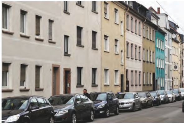
Abb. 59: Erdgeschosszone in der Gärtnerstraße
