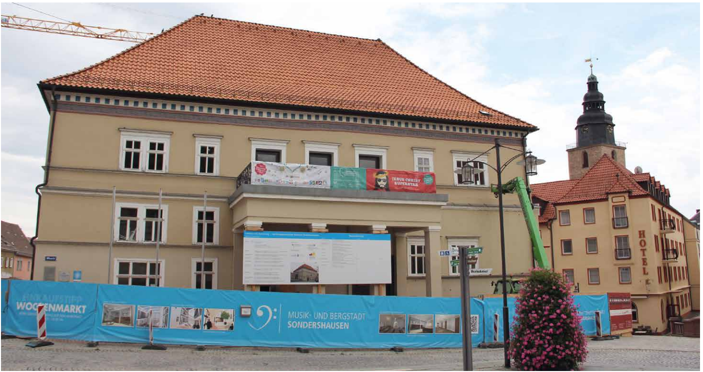
Abbildung 24: Baustelle Rathaus (Foto: Martin Graffenberger)
