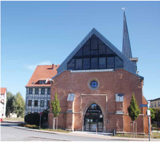
Abbildung 23: Bürgerinnen- und Bürgerzentrum Cruciskirche und Sitz der Wohnungsgesellschaft Wippertal (links) (Foto: Gerhard Görmar)
