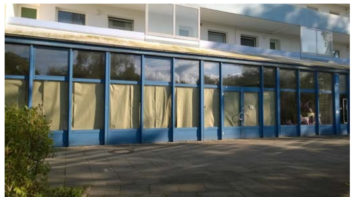
Abbildung 3: Leerstehende Ladenzeile am Rungholtplatz
