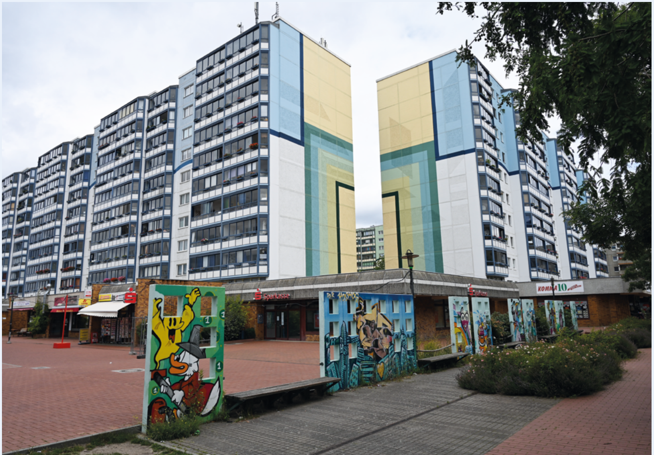
Abbildung 7: In Plattenbauweise errichtete Wohngebäude mit bis zu elf Geschossen prägen das Kosmosviertel (Foto: vhw e. V.)
