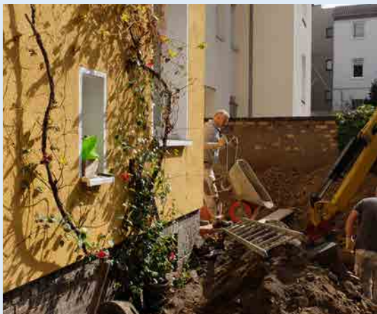
Sanierung der Rohrleitungen, Gartenseite der Merseburger Straße 17
