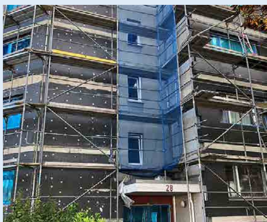
Stetig wird in die Instandhaltung der Gebäude investiert.
