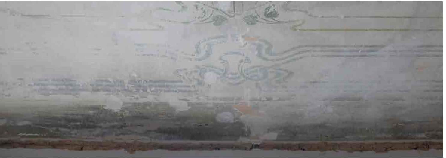
Noch erhaltene Decken- und Wandmalerei in der Merseburger Straße 17.
