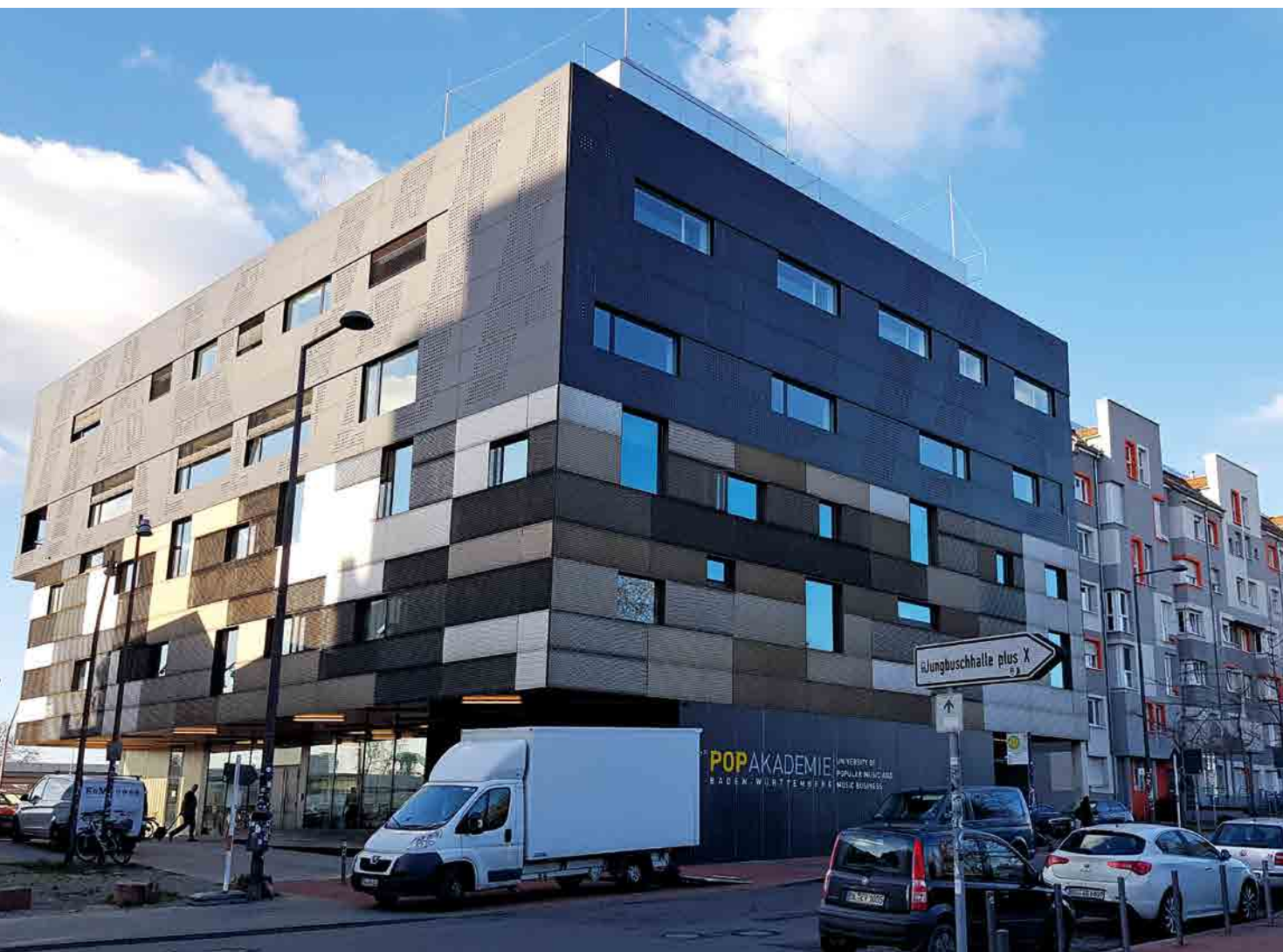
Abb. 12: Mit der Ansiedlung der Popakademie Baden-Württemberg am Verbindungskanal in Mannheim-Jungbusch wurde durch die Stadt eine Aufwertungsstrategie für den Stadtteil verfolgt (eig. Aufnahme, ©ILS)
