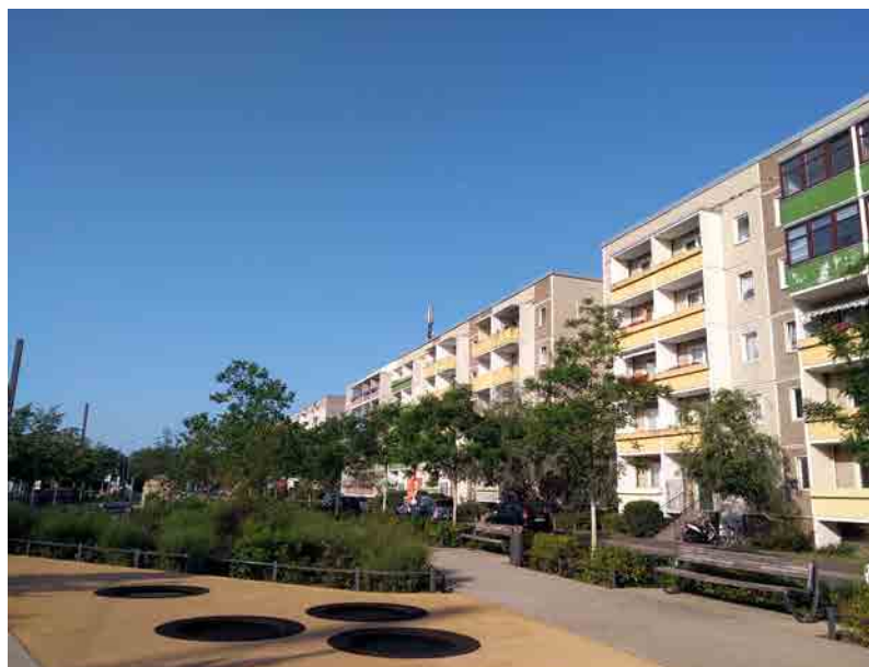
Abbildung 14: Auf der rechten Seite ist noch ein unsanierter Teil der Großwohnsiedlung Potsdam-Drewitz an der Konrad-Wolf-Allee zu sehen; die ehemals mehrspurige Straße wurde bereits verkehrsberuhigt und durch den Konrad-Wolf-Park in der Mitte städtebaulich aufgewertet (eig. Aufnahme, ©ILS)
