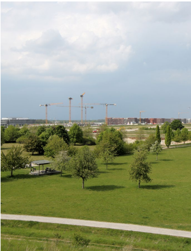
Abb. 5: Wasserbewusste Stadtentwicklung im Neubaugebiet Hannover-Kronsrode. Unter Einbindung einer strikt dezentralen Regenwasserbewirtschaftung sollen hier im interdisziplinären Kontext Antworten auf die Herausforderungen der Auswirkungen des Klimawandels gefunden werden. So wird der Abfluss eines bis zu 30-jährlichen Niederschlagsereignisses gezielt und schadlos aus dem Erschließungsgebiet in zwei multifunktionale Überflutungsflächen geführt werden können. Dabei verdeutlichen die Dimensionen einer 1,2 Meter im Durchmesser großen und 600.000,- Euro teuren notwendigen Dükerrohrleitung die Herausforderungen der Klimaanpassung (Foto: H.-O. Weusthoff, Stadtentwässerung Hannover).
