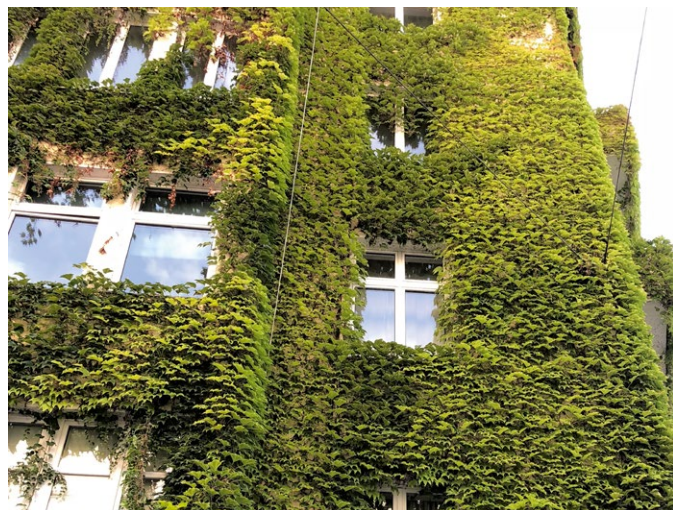
Abb. 1: Fassadenbegrünung erhöht die Aufenthaltsqualität und Isolation des Gebäudes, fördert die Verdunstung und die Biodiversität in Städten (Foto: Ingo Schwerdorf, StEB Köln).
