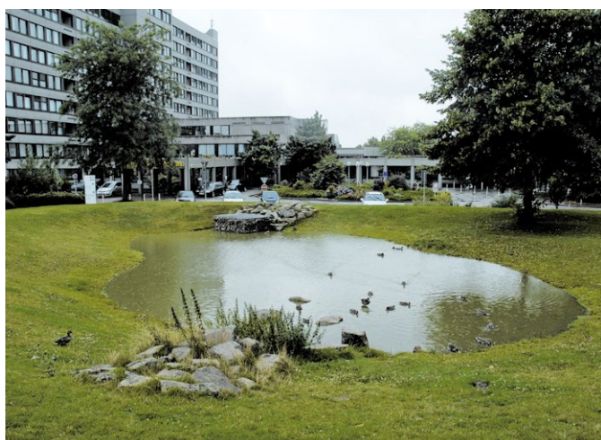
Abb. 2: Muldenversickerung Prosper-Hospital Recklinghausen (Foto: Diethelm Wulfert/EGLV)
