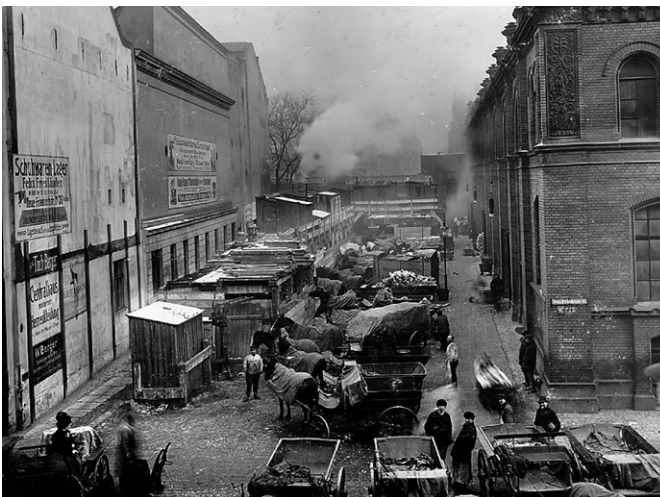
Abb. 2: Baustellenlogistik: Der längste Regenüberlaufkanal Berlins vom Radialsystem XI (heute Erich-Weinert-Straße) zur Friedrichsbrücke an der Spree wird gemauert, hier an der Rochstraße an der Zentralmarkthalle am Alexanderplatz. (Archiv Berliner Wasserbetriebe)
